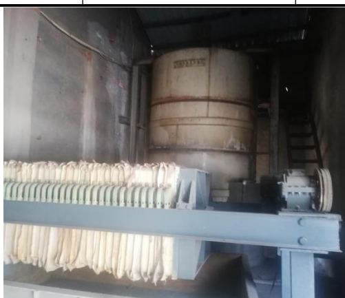
图 4.1.3 储罐类储存设施现场照片
