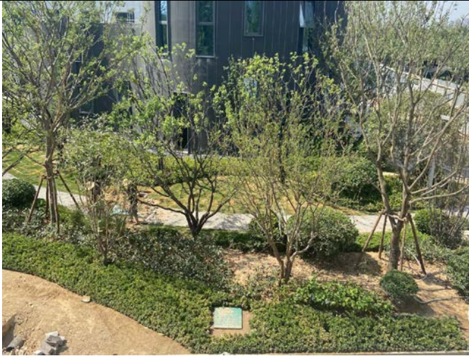
生活污水化粪池
